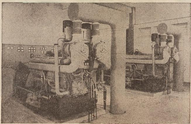
Für das erste schweizerische Leistungs-Atomkraftwerk der Nordostschweizerischen Kraftwerke AG in Beznau an der Aare lieferten wir zwei 545 kVA-Notstromaggregate, die jeweils von einem Sechszylinder-MWM-Dieselmotor TRHS 518 V 16 von 640 PS bei 1500 U/min angetrieben werden.
