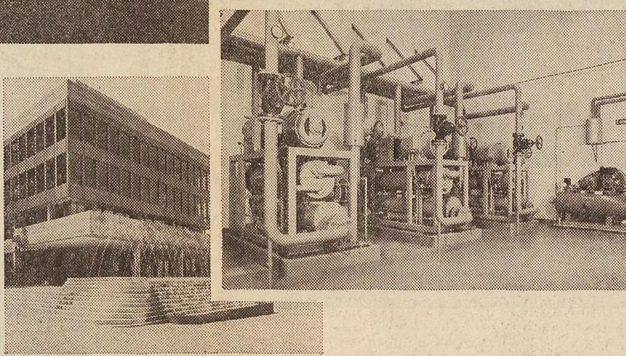
Die grossen Fensterflächen der modernen Hochbauten verunmöglichen eine ausreichende Wärmespeicherung und die Belüftung der Räume wird durch unangenehme Zugescheinungen erschwert. Eine Klimaanlage ist deshalb kein Luxus sondern eine wirtschaftliche Notwendigkeit.
