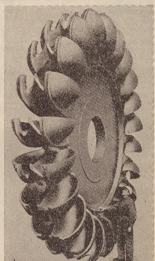
Das grösste Peltonrad der Welt wurde von +GF+ gegossen – für das Kraftwerk New Colgate in Kalifornien/USA. Es leistet 227 000 PS, wiegt 44,5 Tonnen und hat einen Durchmesser von 5,4 Metern.
